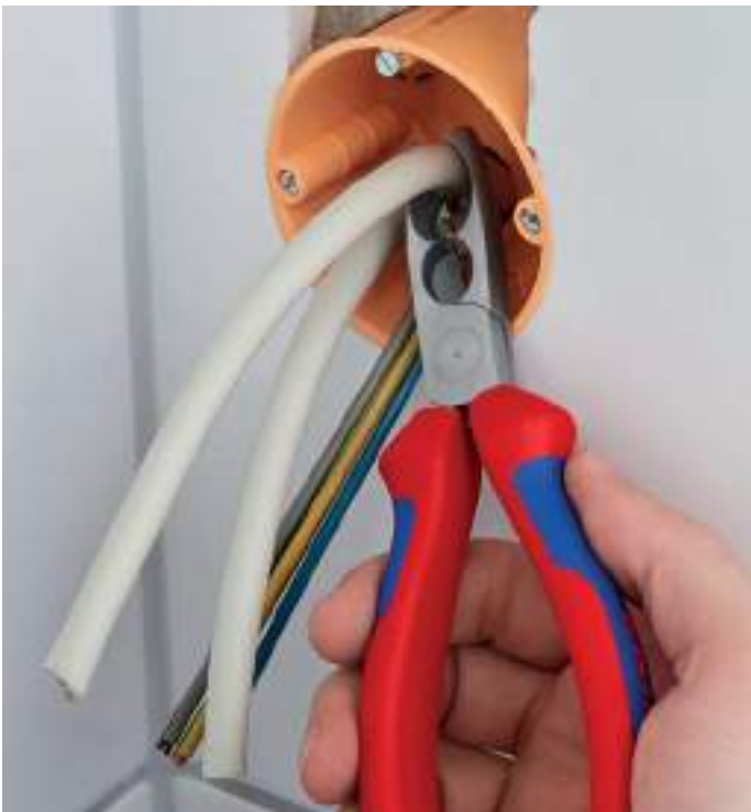
Retirar el aislamiento en la profundidad en cajas empotradas
