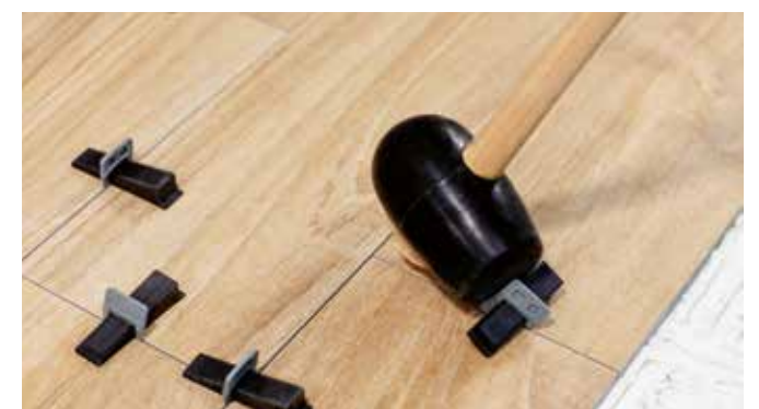
6 Retirar sistema / Retirer le système Remove the system
